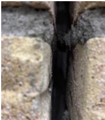
Foto 6: Kijkje in metselwerkdilatatie
