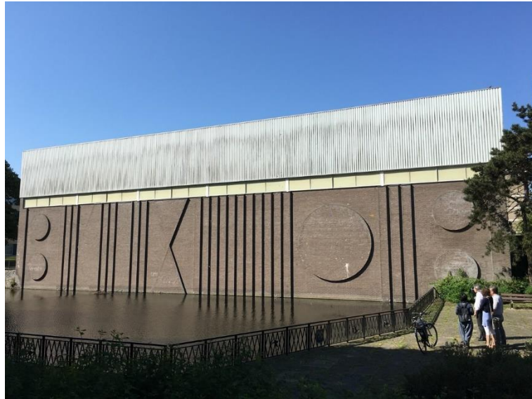
Foto 9: Achtergevel in eerdere staat
