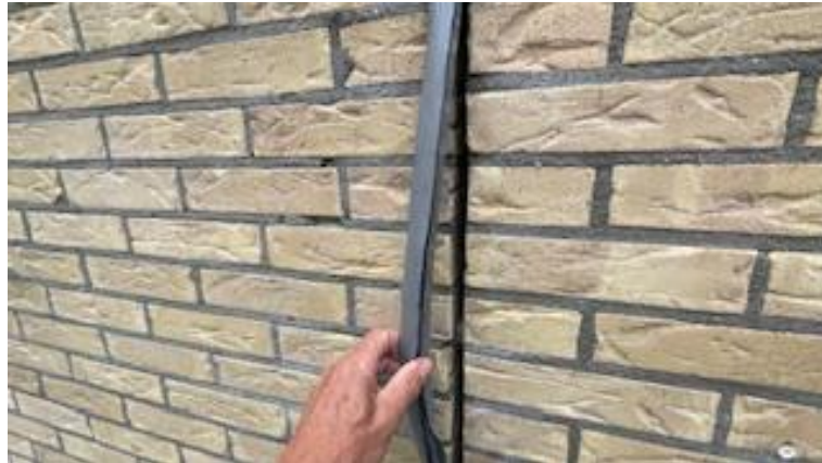
Foto 5: Metselwerkdilatatie in achtergevel
