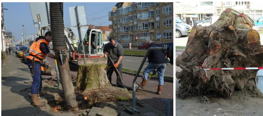
Afbeeldingen: verwijderen boomwortels via alternatieve werkmethode / flinke jongen
